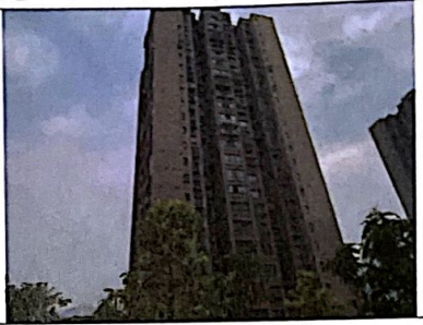
图片 2: 估价对象现状
