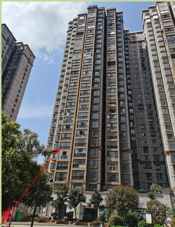
估价对象所在楼栋外观
