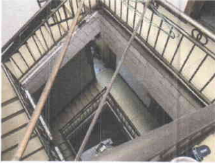
室内楼梯状况
