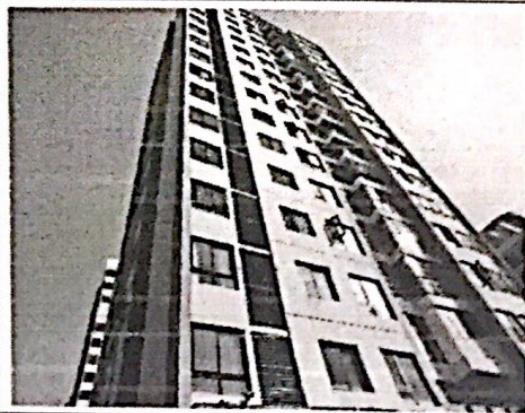
估价对象楼栋外观
