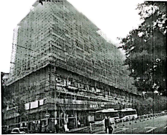
估价对象大楼外观
