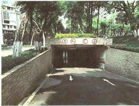
估价对象：车库入口
