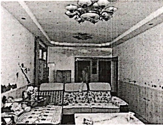
估价对象 3 内部现状
