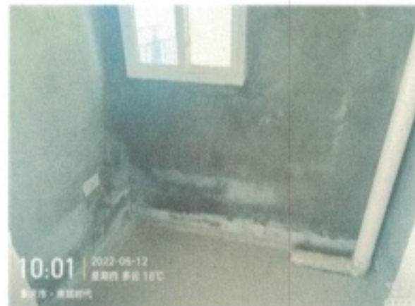
现状照片六：估价对象卫生间
