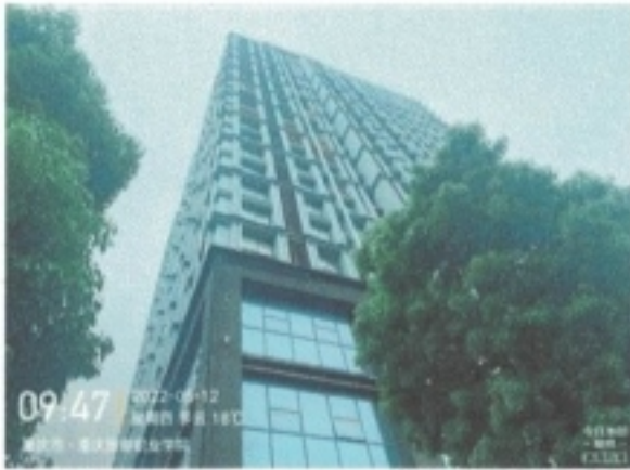
现状照片一：估价对象外观
