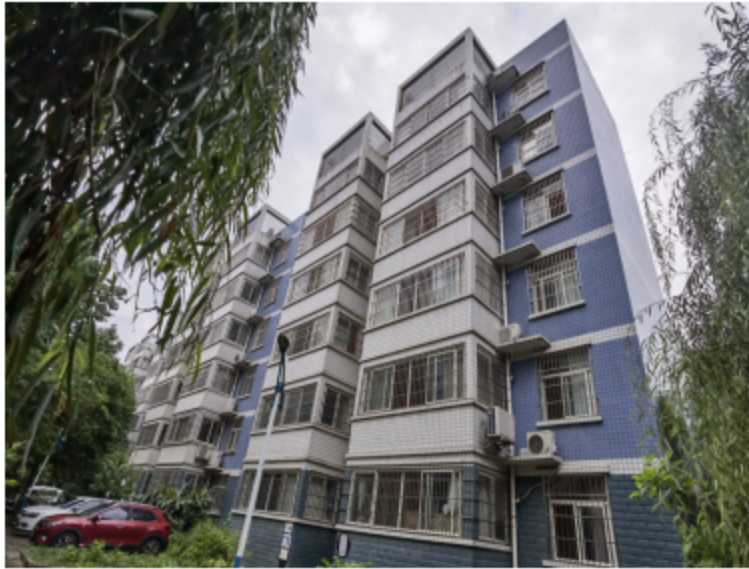
估价对象建筑物外观
