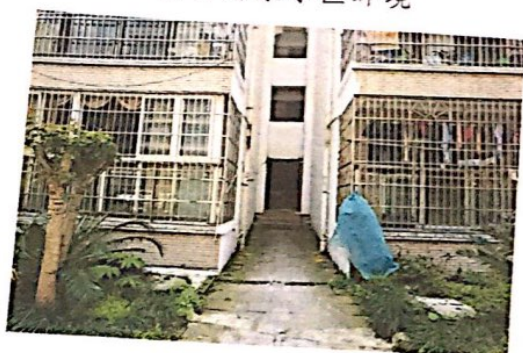
估价对象楼栋出入口
