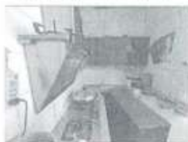
现状照片五：厨房
