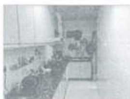
现状照片五：厨房
