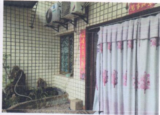
估价对象 2 内部状况
