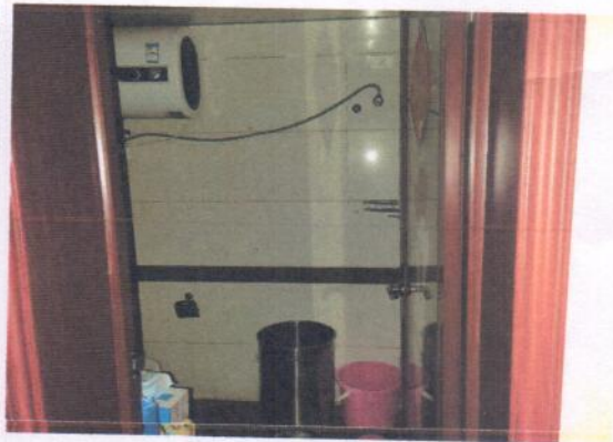
估价对象 2 内部状况
