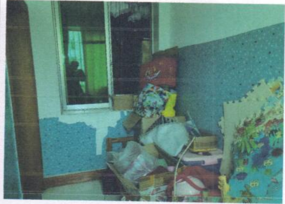
估价对象 1 内部状况
