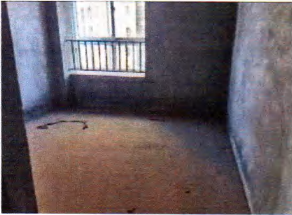
估价对象 1 内部照片
