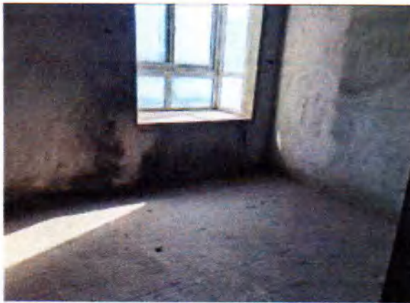
估价对象 2 内部照片
