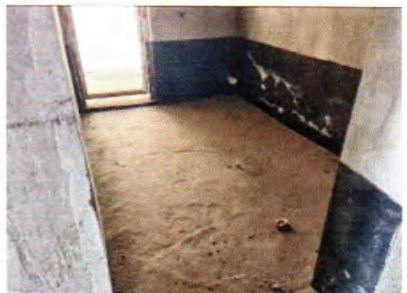
估价对象 2 内部照片
