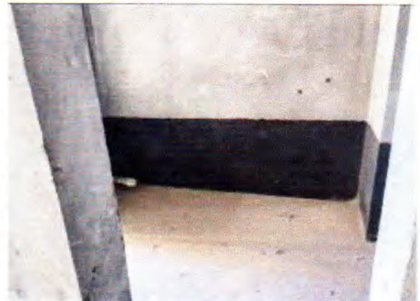
估价对象 1 内部照片
