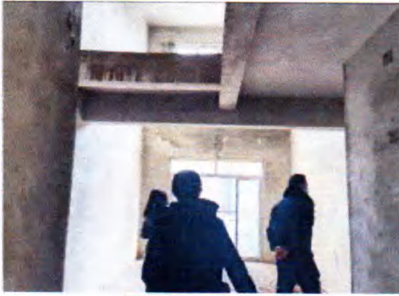
估价对象 2 内部照片
