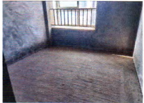
估价对象 1 内部照片
