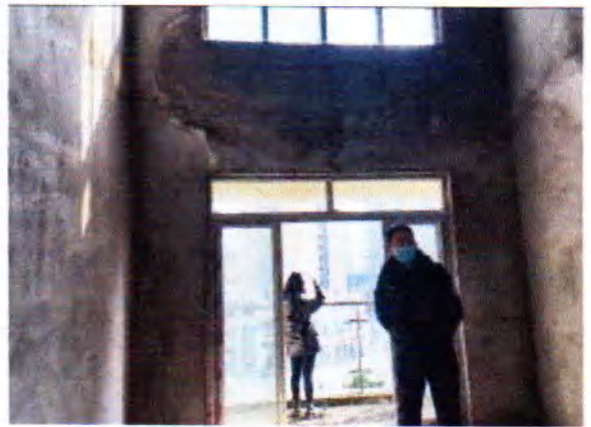
估价对象 2 内部照片
