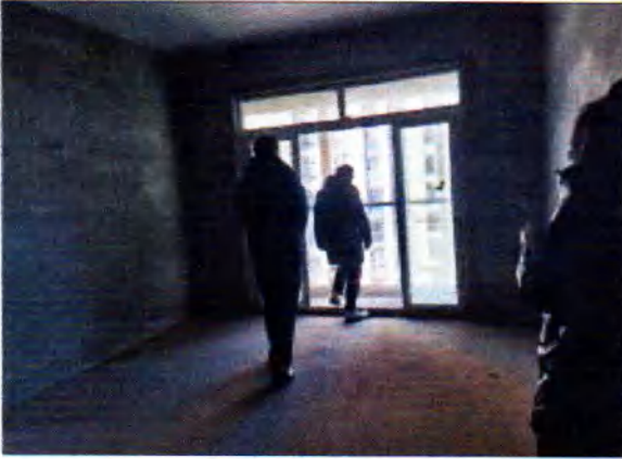
估价对象 1 内部照片
