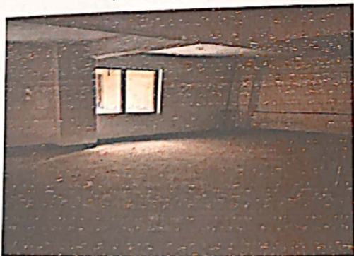
估价对象内部
