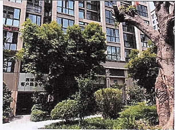
估价对象单元入口
