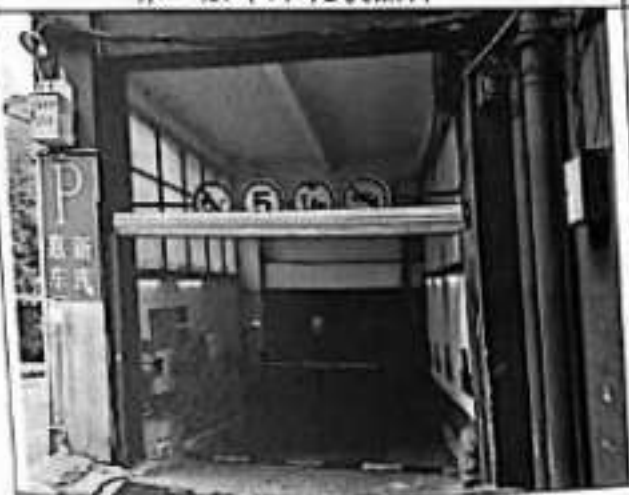
车库入口照片
