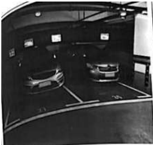
第一层车库现状照片
