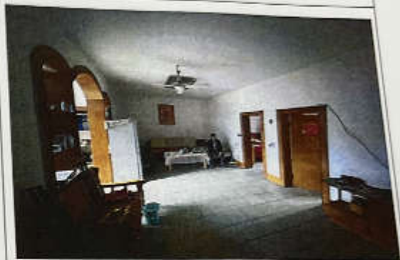
估价对象室内现状
