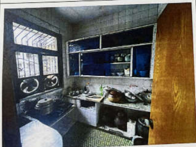
估价对象室内现状
