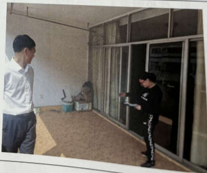
估价对象 1 室内现状
