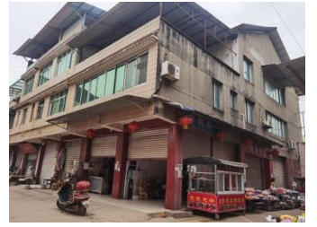
估价对象楼宇外观
