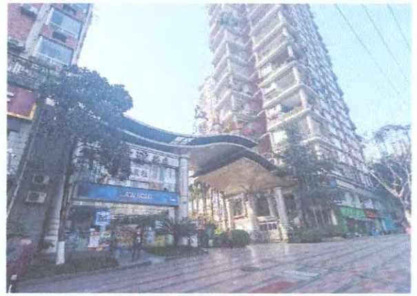
估价对象小区外观照片
