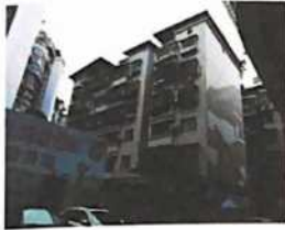
现状照片一：楼栋外观
