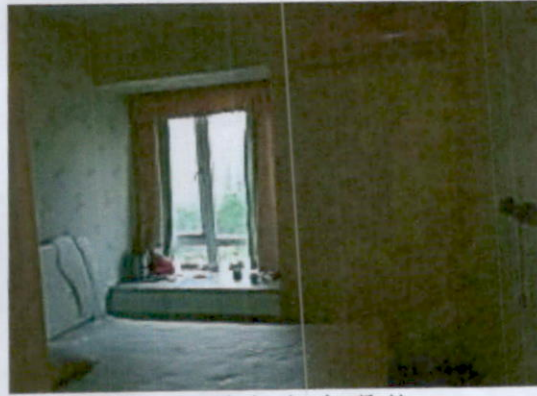
估价对象室内现状
