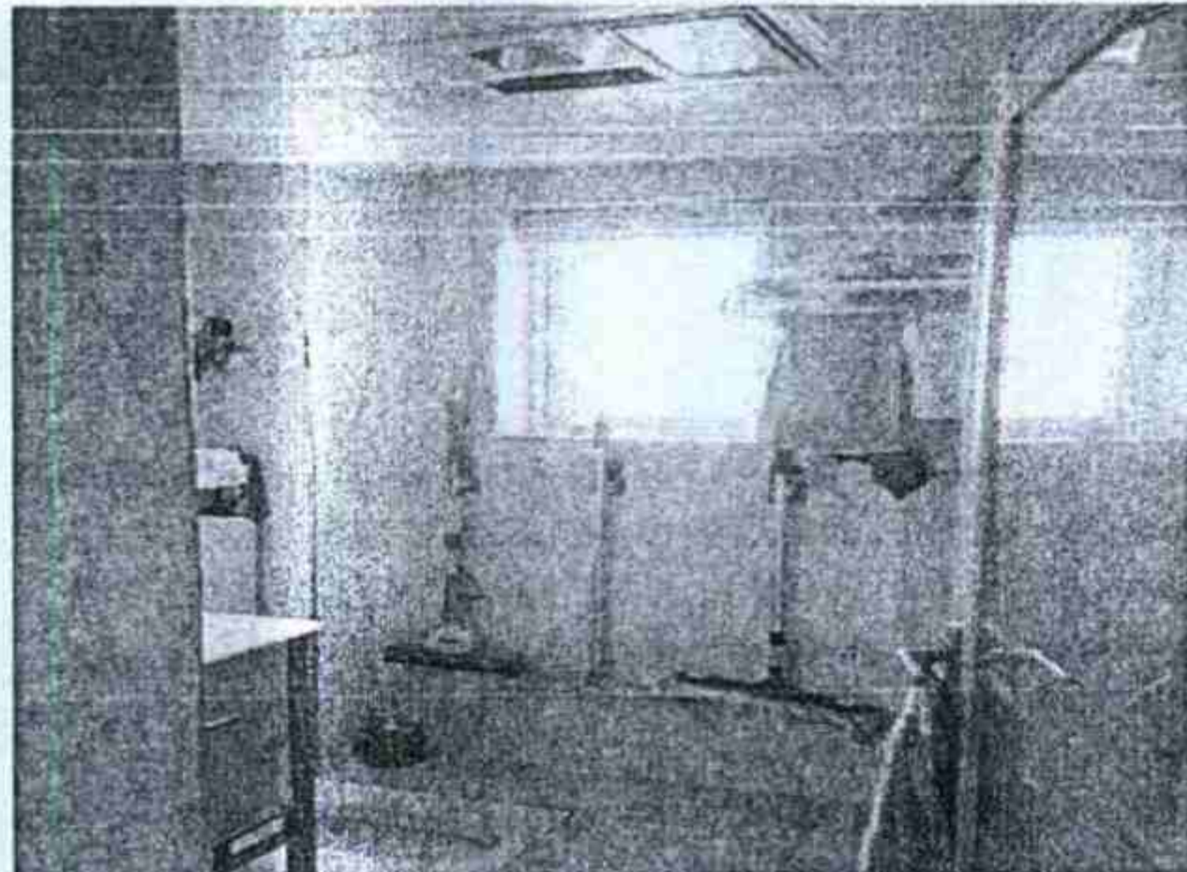
估价对象内部现状
