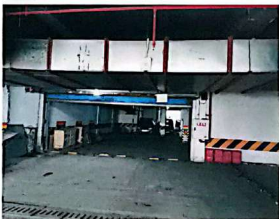
估价对象内部现状
