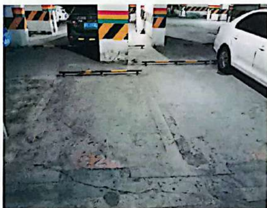
估价对象内部现状
