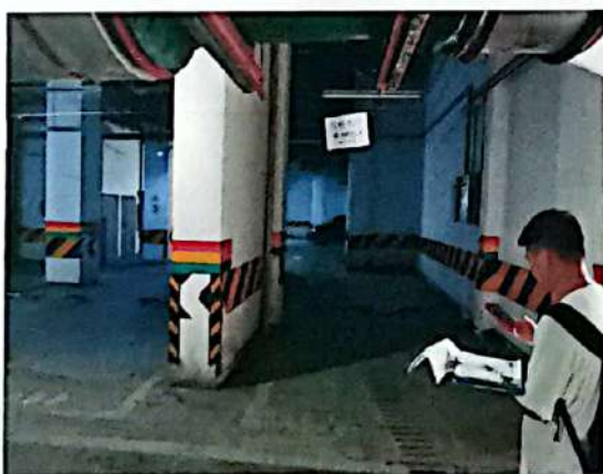
估价对象内部现状
