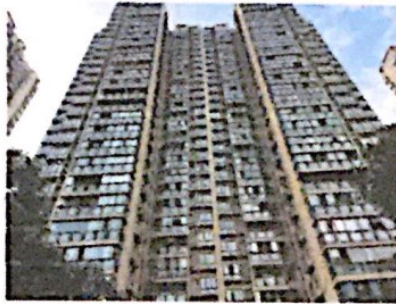
估价对象楼栋外观
