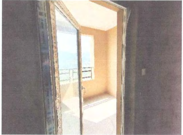
估价对象阳台现状
