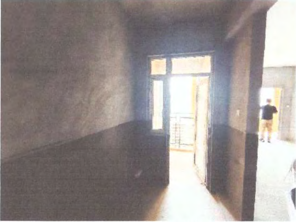
估价对象厨房现状
