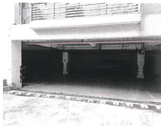
估价对象车库入口
