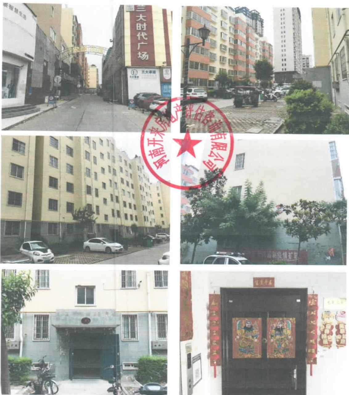
封丘县黄池路中段路东宏盛花园 3 幢 2 单元 6 层 601 西号房地产照片
