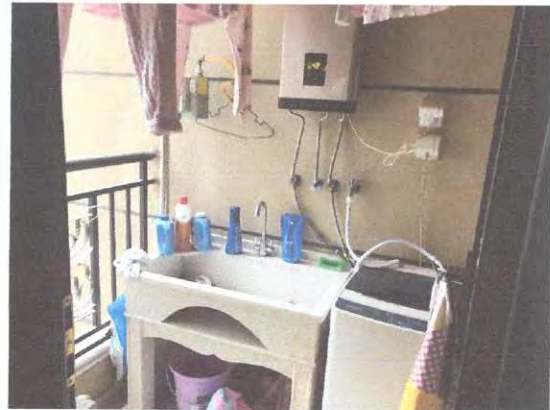
估价对象室内现状
