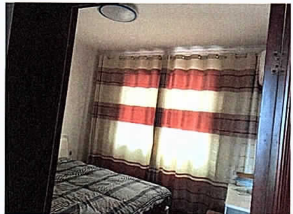
估价对象内部
