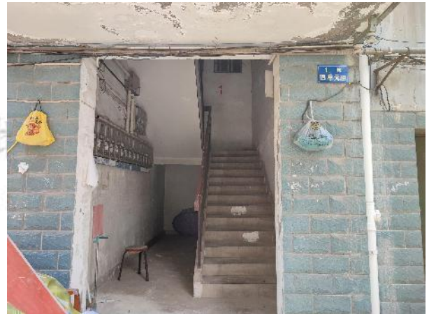
估价对象单元入口
