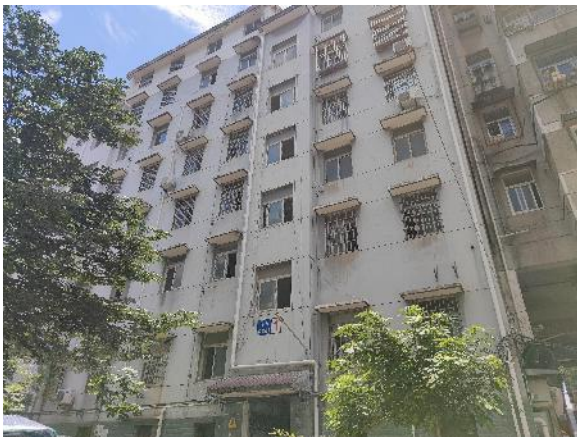
估价对象楼栋外观
