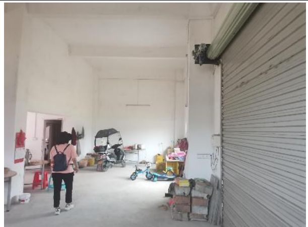
首层室内现状 2
