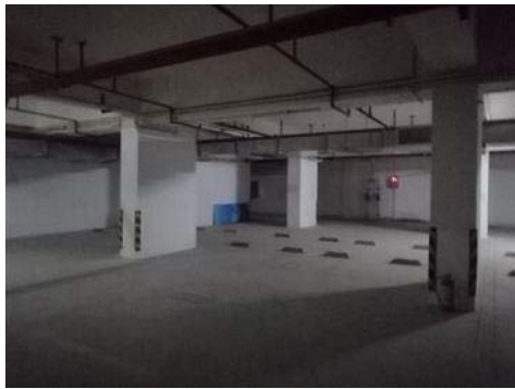
地下 2 层车位现状
