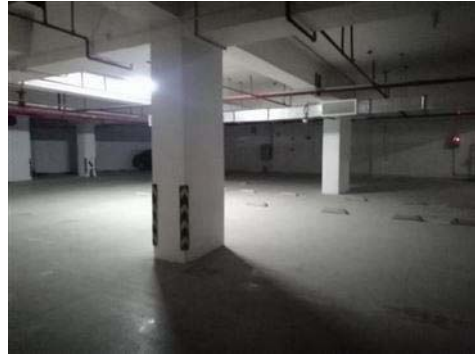
地下 2 层车位现状
