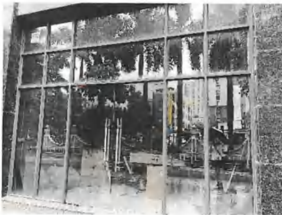
首层 01 号商铺门铺照
