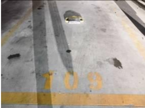
估价对象部分车位
