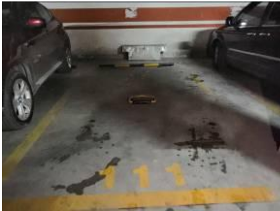
估价对象部分车位
