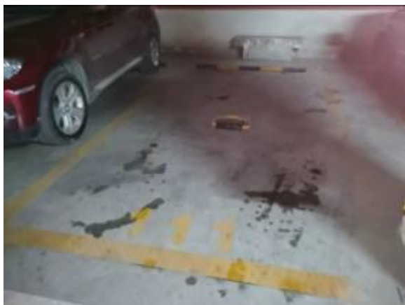
估价对象部分车位
