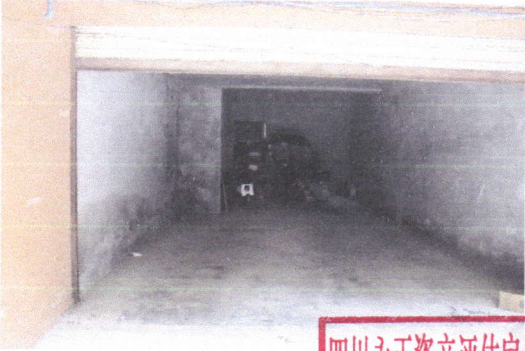
滨河阳光4幢1层5号车库现状
