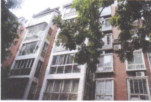
滨河阳光4幢1层5号、6号车库楼栋外观
