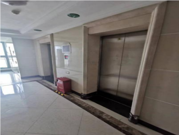
估价对象电梯间
