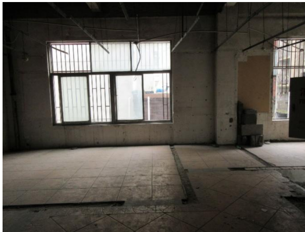
估价对象所在二层室内
