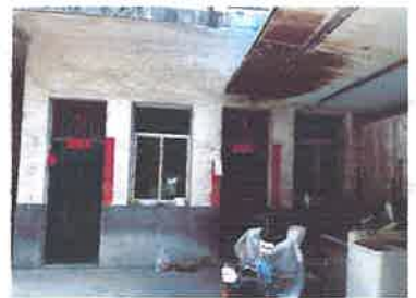
估价对象内部状况-1
