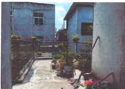
估价对象内部状况-11
