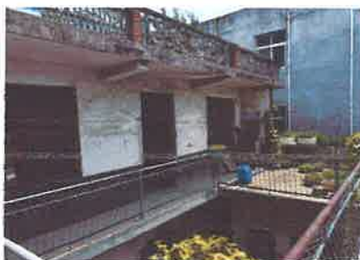
估价对象内部状况-12
