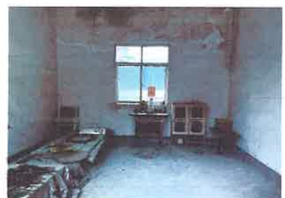
估价对象内部状况-13
