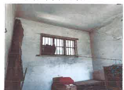
估价对象内部状况-16
