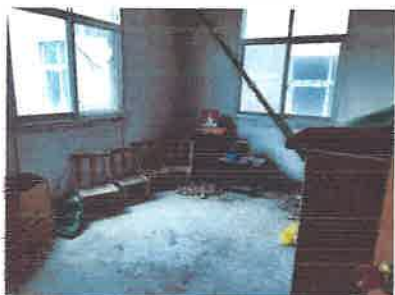
估价对象内部状况-14
