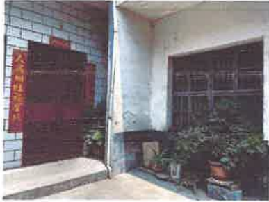
估价对象内部状况-2
