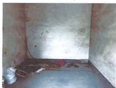
估价对象内部状况-15
