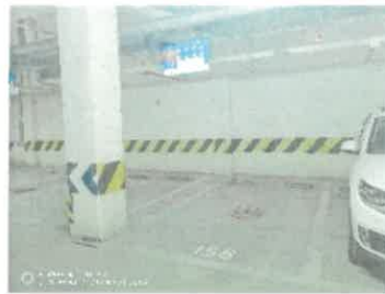
估价对象室内现状
