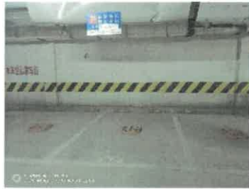
估价对象室内现状
