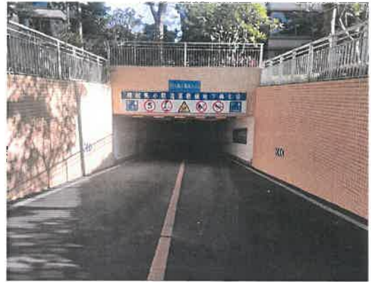
估价对象所在停车库入口
