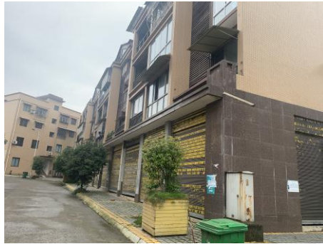
所在建筑物外观
