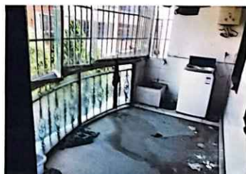
估价对象内部状况
