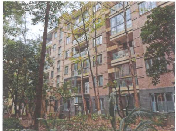
4、估价对象所在建筑物外观
