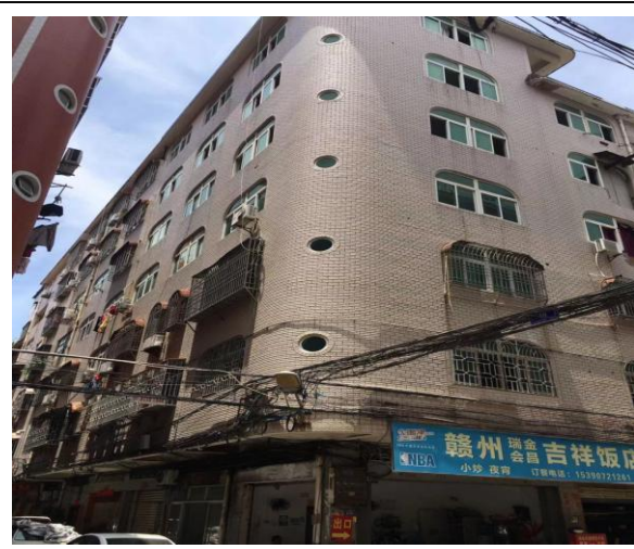
外部状况（楼栋外观）
