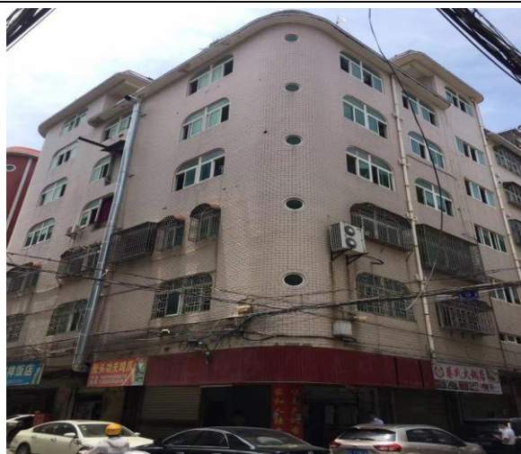
外部状况（楼栋外观）
