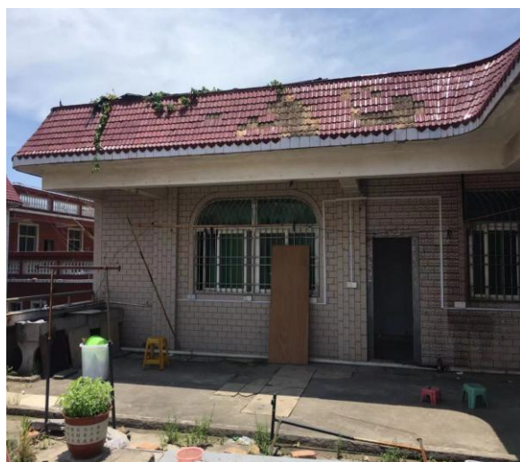
估价对象第七层未办证建筑状况
