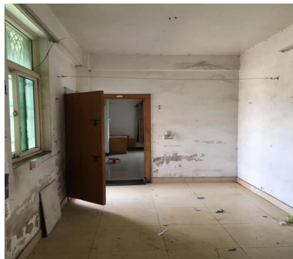
估价对象第七层未办证建筑状况
