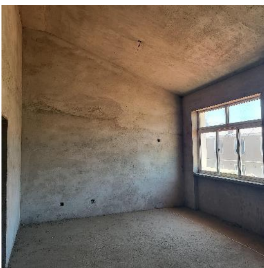
估价对象室内
