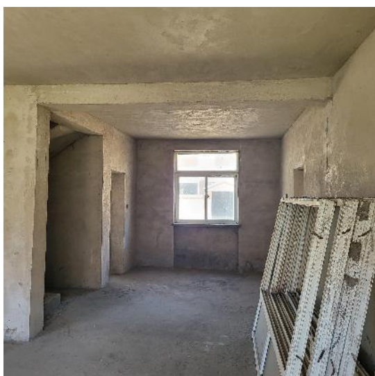
估价对象室内
