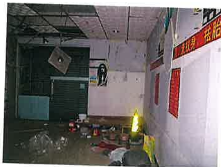
估价对象晋煌一路5、7号内部状况
