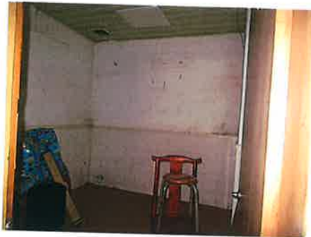
估价对象晋煌一路1、3号内部状况
