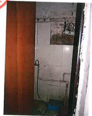
估价对象晋煌一路5、7号内部状况
