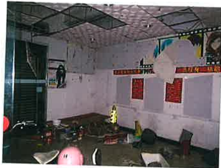
估价对象晋煌一路5、7号内部状况
