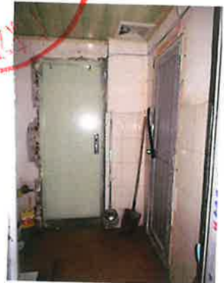
估价对象晋煌一路1、3号内部状况
