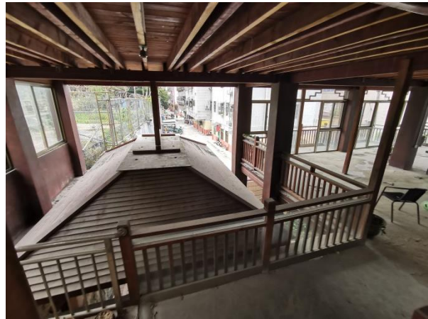
加建部分室内
