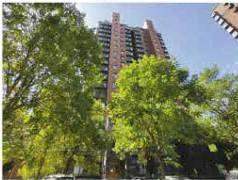
所在项目楼外观
