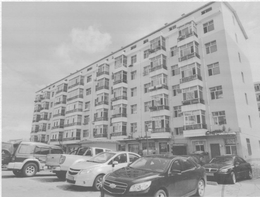
九三管理局生态家园9号楼4单元302室 张学忠房屋的照片
